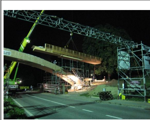
Wildnispark Zürich, Langenberg Albisstrasse; Einheben der Passerelle
